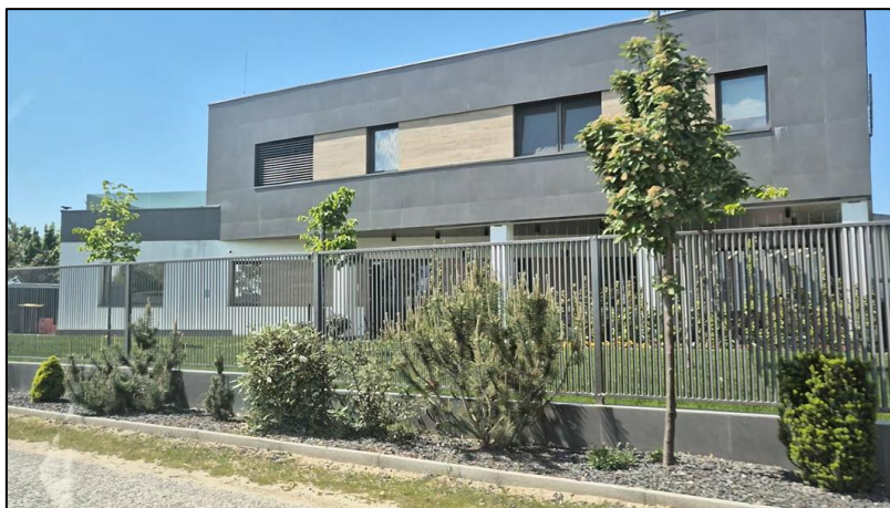
Oldalhomlokzat a Vásártér utca mentén
