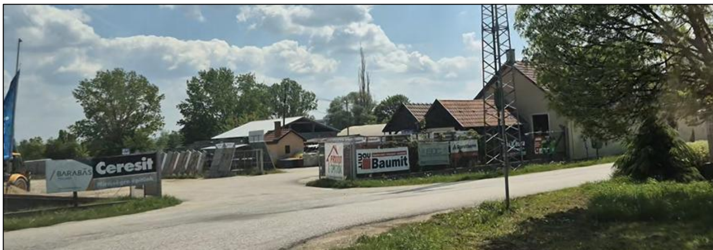
Építőanyag telep a Repülőtérre vezető út bal oldalán, földszintes épülettel, kiegészítő építményekkel
